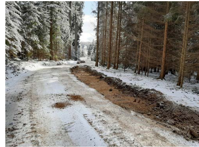
Die Vorbereitung laufen auf Hochtouren: Der Wegausbau Ende 2020
