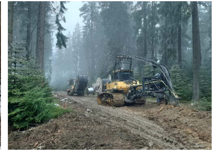
Der Kabelpflug verlegt ein Erdkabel zum Umspannwerk Sallingberg
